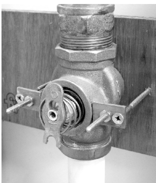
Fijación de válvula 368 para inodoro.
