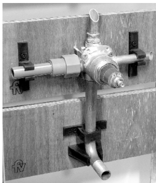
Fijación de juego termostático.
