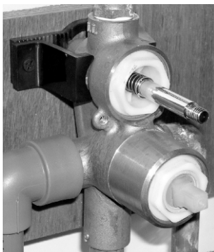
Fijación de juego monocomando.
