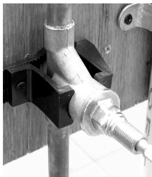
Fijación de llave de paso 489.
