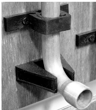
Fijación de codo pico salida.
