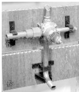
Fijación de juego termostático.
