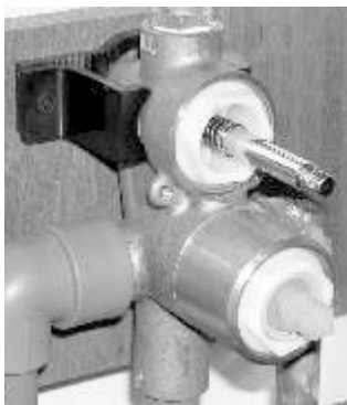
Fijación de juego monocomando.
