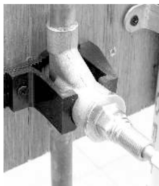
Fijación de llave de paso 489.
