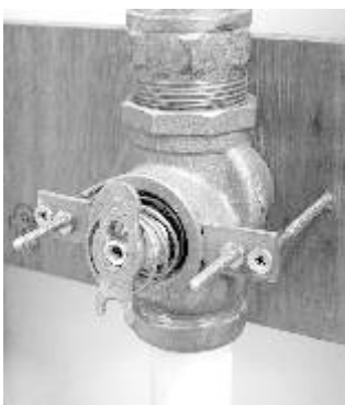
Fijación de válvula 368 para inodoro.
