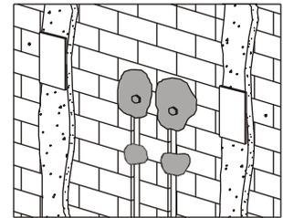
Asegure las cañerías con cemento. Retire la plantilla y cemente los codos.
